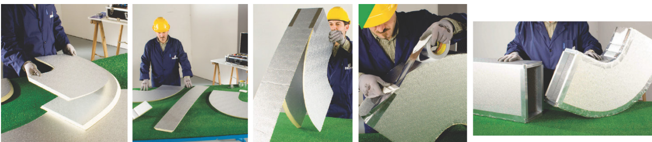
Exemple de réalisation d'un coude à 90° :
